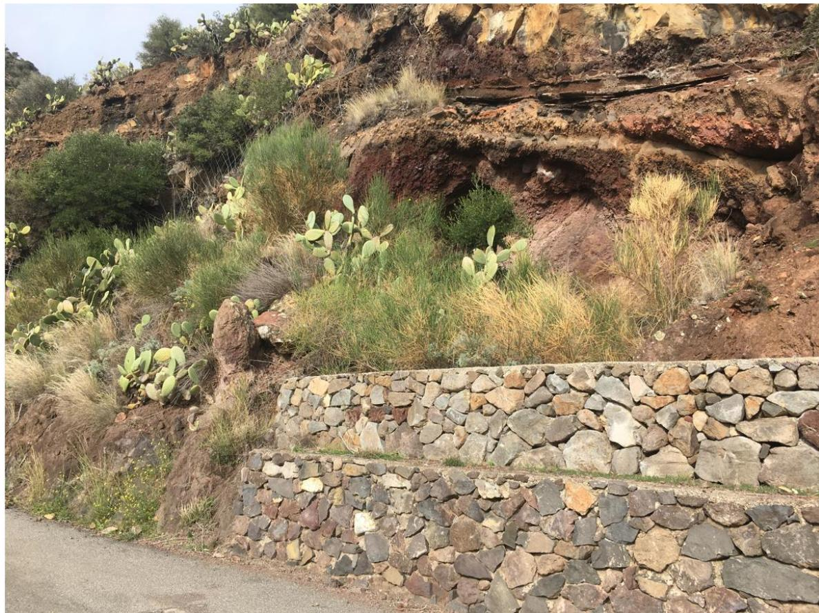
Foto 44 - Necessità di sottomurazione e prolungamento muro di blocchi e calcestruzzo, nel tratto ubicato nello stralcio sopra riportato (IMG 3033 del 11 01 2021 11:12). INTERVENTO 2 -TIPO B ed E- su 450m2
