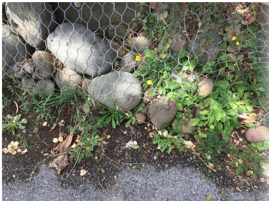
Foto 39 - Rete leggera da irrobustire con funi ancorate e svuotare al piede (IMG 4212 del 19 03 202 12:37). INTERVENTO 13 -TIPO F, G e C – rispettivamente su 80, 80 e 1600m<sup>2</sup>
