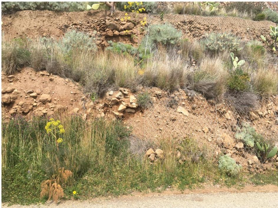
Foto 15 - Inizio rete leggera, da rinforzare con funi ed ancoraggi (IMG 4178 del 19 03 202 11:55).
