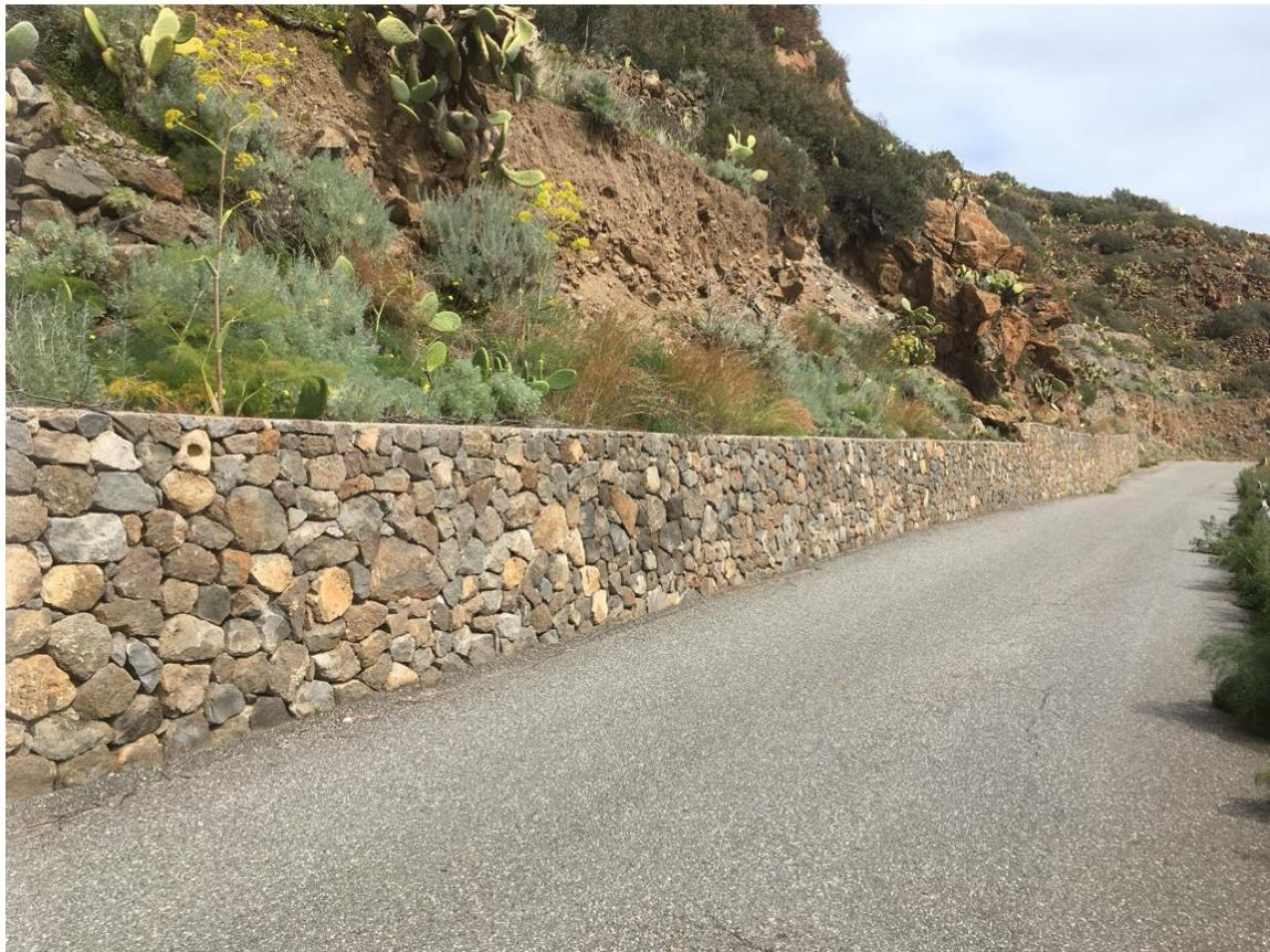
Foto 21 - Tratto sprovvisto di rete da trattare con disgaggi e sottomurazioni locali e installazione di rete e funi ancorate sopra esistente muro (IMG 4184 del 19 03 202 12:05)
