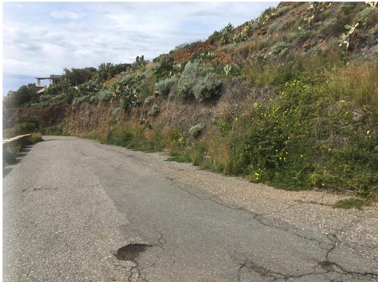
Foto 18 - Rampa con difesa di rete leggera che necessita di pulizia e rinfianco di funi o pannelli di irrobustimento (IMG 4181 del 19 03 202 11:59). INTERVENTO 8 -TIPO C- su 1200m<sup>2</sup>
