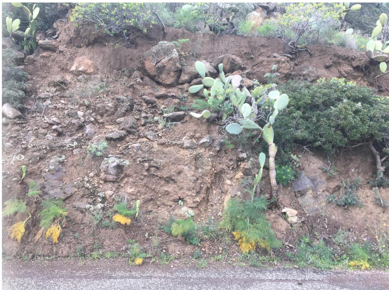
Foto 43 - Necessità di rete leggera da irrobustire con funi ancorate, nel tratto ubicato nello stralcio planimetrico sopra riportato (IMG 4088 del 18 03 2021 10:59). INTERVENTO 1 -TIPO B- su 2016m<sup>2</sup>
