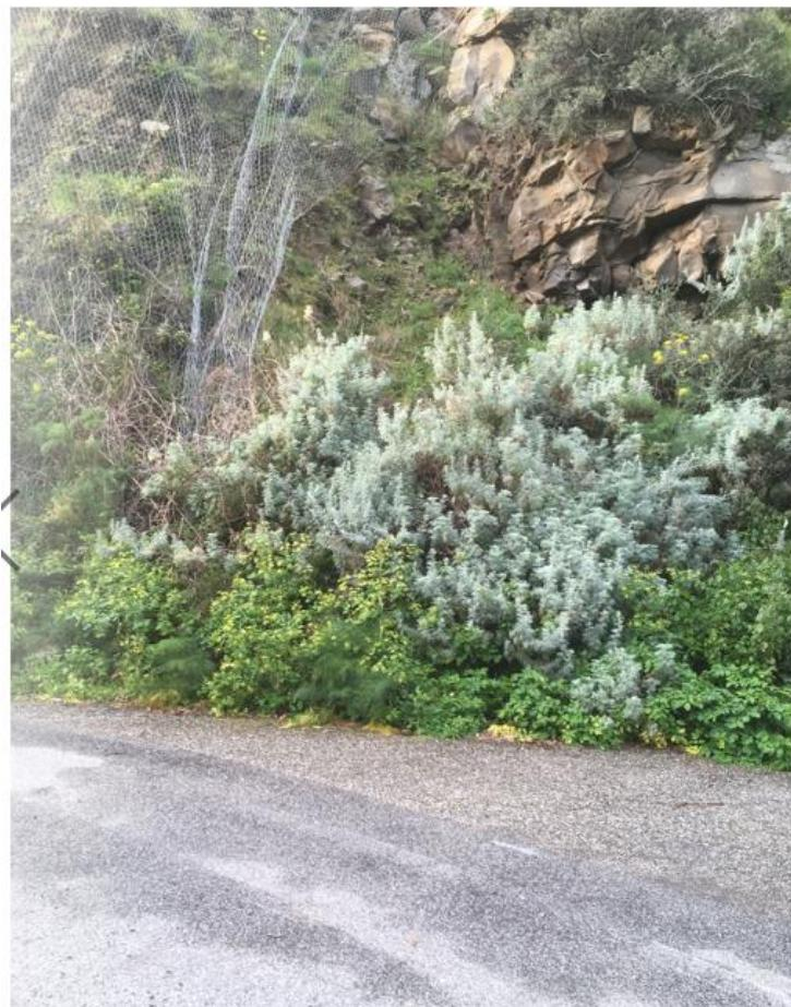
Foto 10 - Fine rete leggera, da rinforzare con ancoraggi (IMG 4155 del 19 03 2021 07:47). INTERVENTO 4 -TIPO C- su 600m<sup>2</sup>
