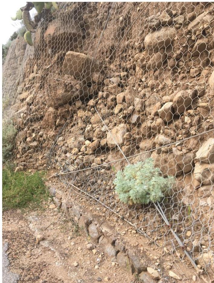
Foto 29 - Tratto di rete leggera irrobustita da funi ancorate che necessita di apertura e vuotamento, ubicata nello stralcio planimetrico sopra riportato, (IMG 4192 del 19 03 202 12:19). INTERVENTO 10 - TIPO F- su 150m<sup>2</sup>
