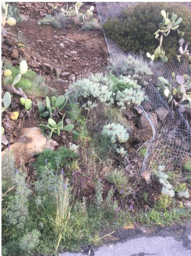
Foto 6 - Fine rete di cui sopra, da rinforzare con funi ed ancoraggi (IMG 4142 del 19 03 2021 07:03)
