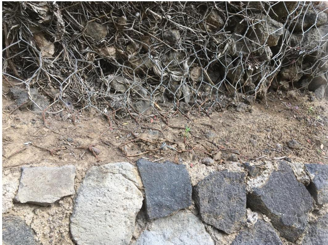
Foto 42 - Rete leggera da irrobustire con funi ancorate (IMG 4216 del 19 03 202 12:42). INTERVENTO 15 -TIPO F, G e C – rispettivamente su 50, 50 e 800m<sup>2</sup>
