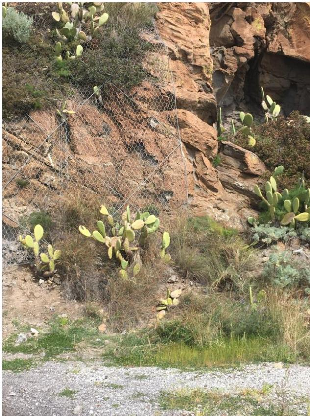
Foto 17 - Fine rete già rinforzata con funi e ancoraggi (IMG 4180 del 19 03 202 11:57)
