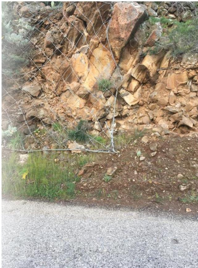
Foto 8 - Fine rete a maglia larga di cui sopra, da rinforzare con ancoraggi (IMG 4153 del 19 03 2021 07:40). INTERVENTO 5 -TIPO D- su 2600m<sup>2</sup>
