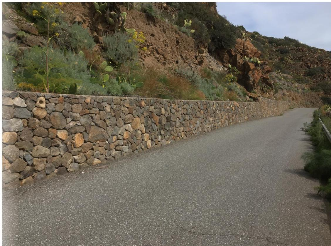
Foto 19 - Tratto sprovvisto di rete da trattare con disgaggi e sottomurazioni locali e installazione di rete e funi ancorate sopra esistente muro (IMG 4182 del 19 03 202 12:05). INTERVENTO 9 -TIPO A- su 4000m<sup>2</sup>
