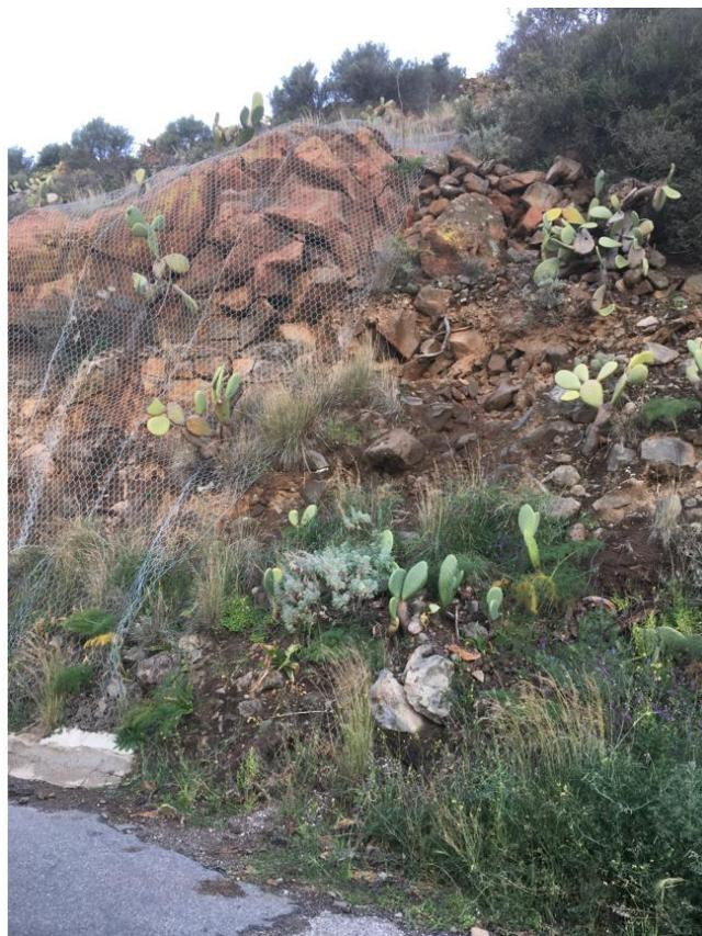
Foto 4 - Inizio rete leggera da rinforzare con funi ed ancoraggi (IMG 4129 del 19 03 2021 06:47)
