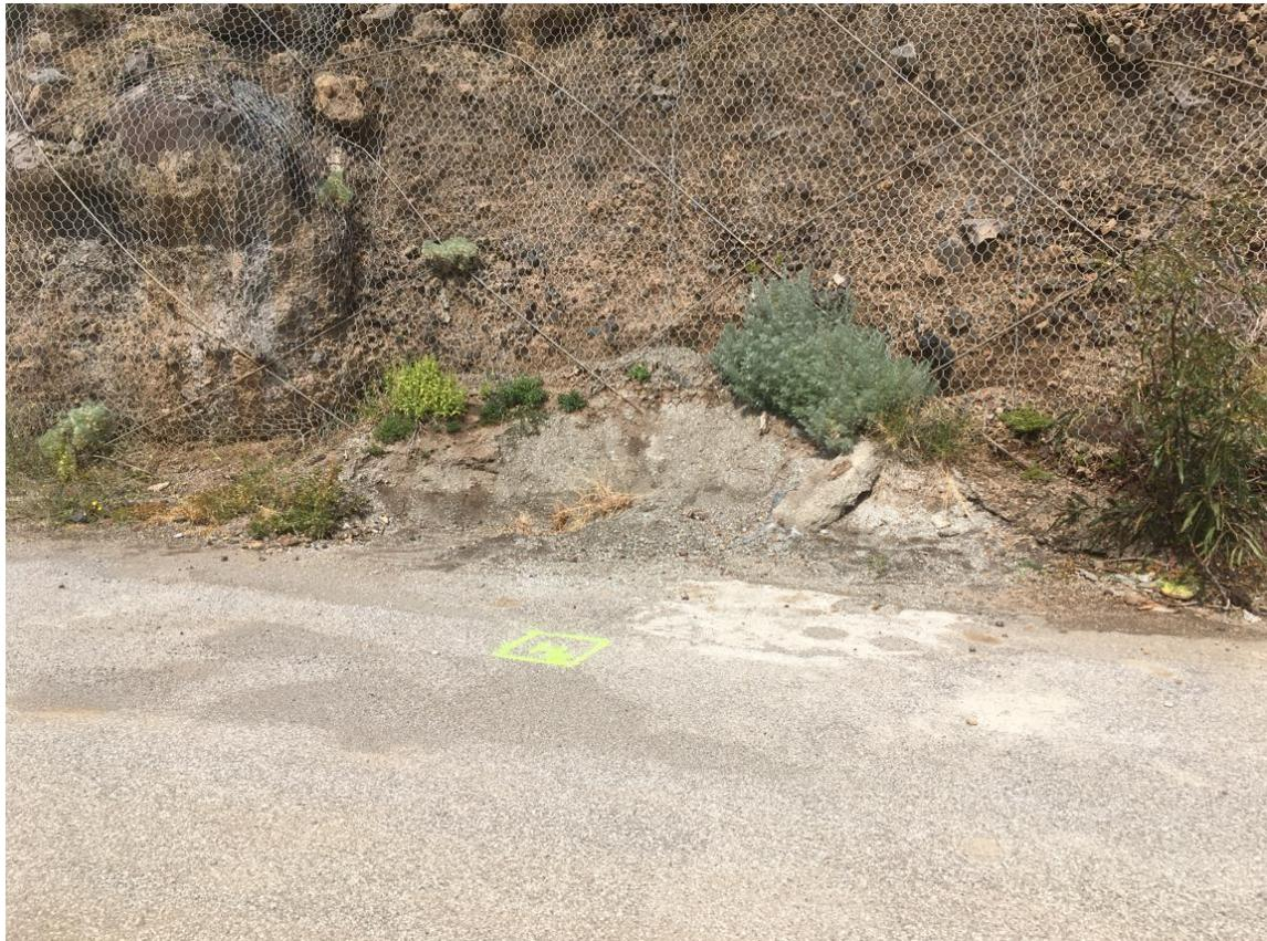
Foto 34 - Rete leggera con funi ancorate da svuotare localmente (IMG 4199 del 19 03 202 12:28).
