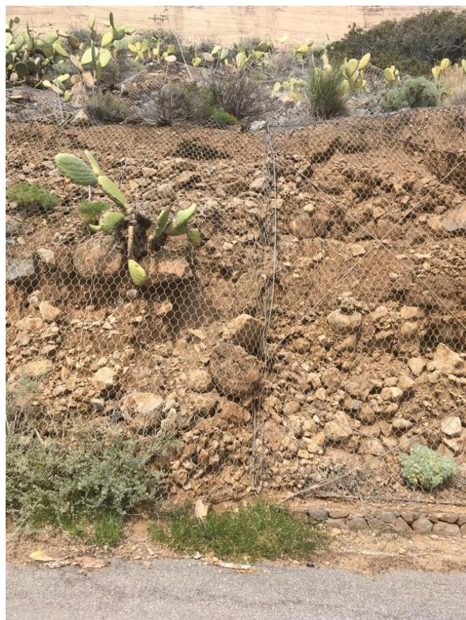
Foto 28 - Tratto di rete leggera e successiva rete leggera irrobustita da funi ancorate, ubicata nello stralcio planimetrico sopra riportato (IMG 4191 del 19 03 202 12:18)
