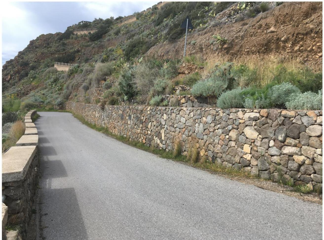
Foto 30 - Difesa di muro di blocchi e cemento sormontato da rete con funi ed ancoraggi, ubicata nello stralcio planimetrico sopra riportato, (IMG 4193 del 19 03 202 12:21)
