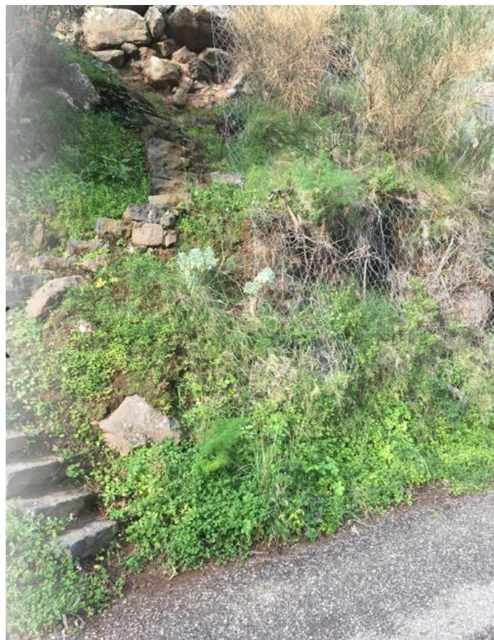
Foto 9 - Inizio rete leggera, ubicata nello stralcio planimetrico sopra riportato, da rinforzare con funi ed ancoraggi (IMG 4154 del 19 03 2021 07:46). INTERVENTO 4 -TIPO C- su 600m<sup>2</sup>
