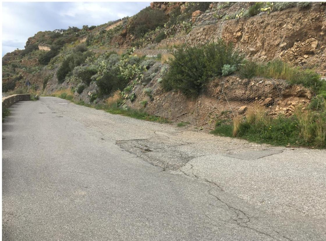
Foto 26 - Rete leggera irrobustita da funi ancorate ubicata nello stralcio planimetrico sopra riportato, (IMG 4189 del 19 03 202 12:12)
