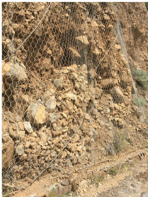
Foto 24 – Necessità di vuotamento rete con funi ancorate seguentemente ad esistente muro estesa sul tornante (IMG 4187 del 19 03 202 12:09)
