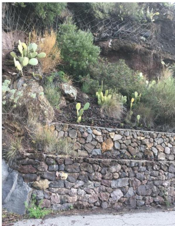
Foto 12 - Mezzeria e zona fine rete a maglia larga di cui sopra, da rinforzare con ancoraggi e necessità di sottomurazione fra bordo inferiore rete e muro di blocchi e malta di cemento (IMG 4157 del 19 03 2021 07:53). INTERVENTO 2 -TIPO B ed E- su 450m<sup>2</sup>
