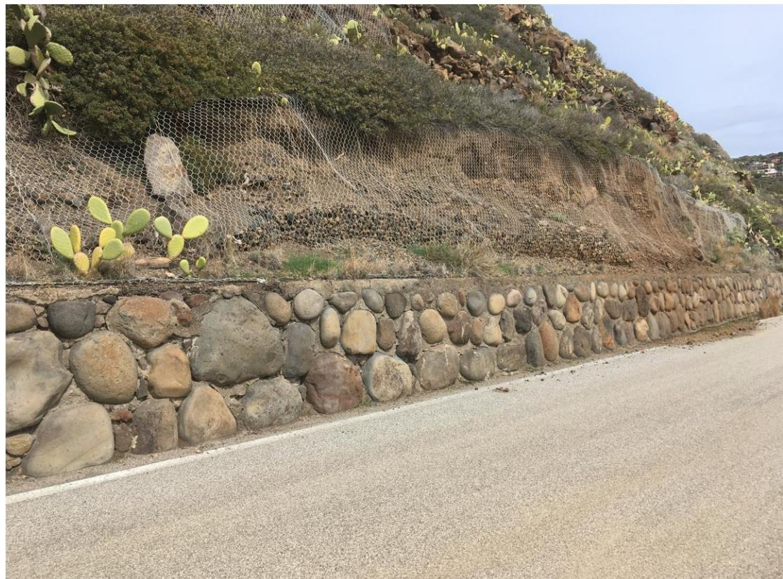
Foto 35 - Rete leggera ubicata nello stralcio planimetrico sopra riportato, da svuotare localmente e sarcire al piede nonché irrobustire con funi ancorate; il muro di cemento e blocchi che appaiono provenienti dal fondale dei paraggi potrebbe essere sollevato con impiego di gabbioni, ove vi fosse materiale lapideo disponibile in loco (IMG 4200 del 19 03 202 12:29). INTERVENTO 12 -TIPO F, G e C – rispettivamente su 200, 200 e 2000m<sup>2</sup>
