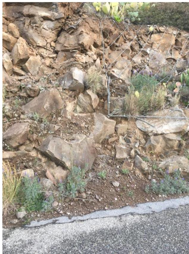
Foto 7 - Inizio rete a maglia larga ubicata ed ubicata nello stralcio planimetrico sopra riportato, da rinforzare con ancoraggi (IMG 4152 del 19 03 2021 07:38). INTERVENTO 5 -TIPO D- su 2600m<sup>2</sup>
