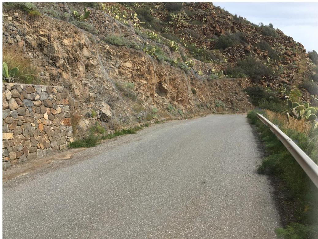
Foto 22 - Tornante provvisto di rete con funi ancorate, ubicata come nello stralcio planimetrico sopra riportato, seguentemente ad esistente muro e per un tratto di tornante (IMG 4185 del 19 03 202 12:07).
