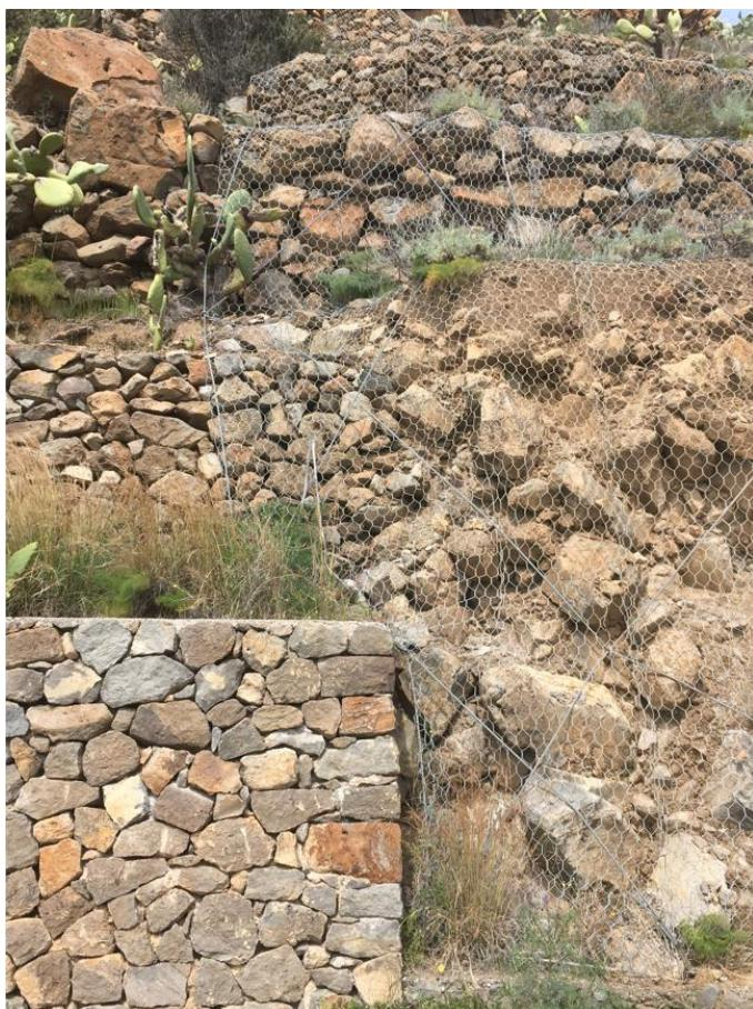
Foto 23 - Sezione di inizio rete con funi ancorate seguentemente ad esistente muro estesa sul tornante (IMG 4186 del 19 03 202 12:07)
