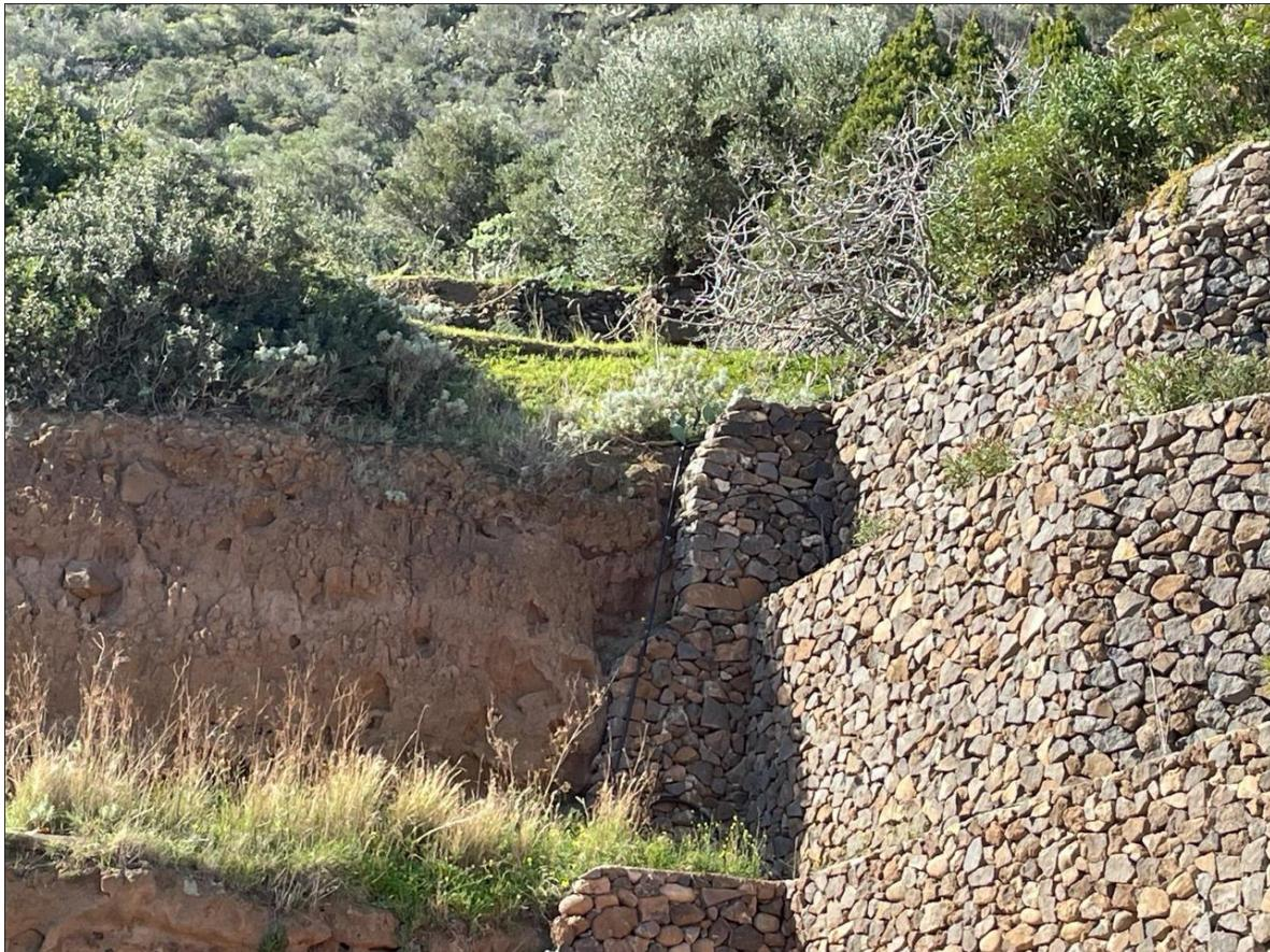
Figura D1 - Rivestimento di parete di vulcanite con muratura di blocchi selezionati dalla roccia locale legati con malta e disposti a parete sub verticale con gradonatura ogni 2-3m; zona di Filicudi Porto
