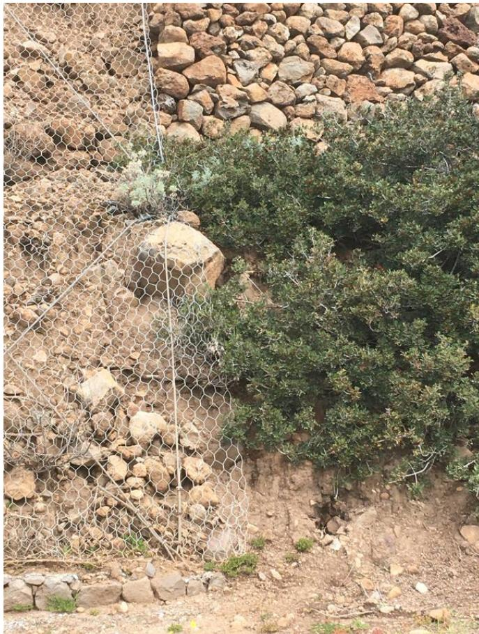
Foto 25 - Fine rete con funi ancorate estesa sul tornante (IMG 4188 del 19 03 202 12:11)
