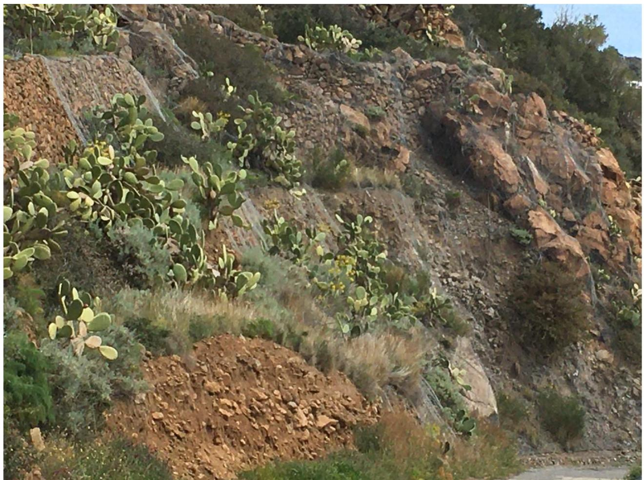
Foto 14 - Vista rete leggera, ubicata nello stralcio planimetrico sopra riportato, da rinforzare con funi ed ancoraggi (IMG 4177 del 19 03 202 11:48). INTERVENTO 7 -TIPO C- su 4000m<sup>2</sup>
