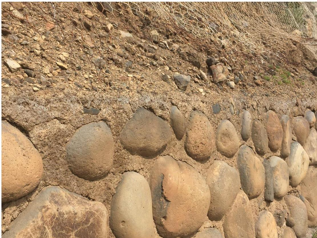
Foto 36 - Rete leggera da svuotare localmente e sarcire al piede nonché irrobustire con funi ancorate (IMG 4201 del 19 03 202 12:30). INTERVENTO 12 -TIPO F, G e C – rispettivamente su 200, 200 e 2000m<sup>2</sup>
