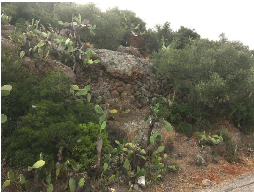
Figura D6 - Esempio di sottomurazione di massi instabili a monte della strada in esame, località Canale - Rocca di Ciauli (cfr. anche Foto 1 e 2 in Appendice A)
