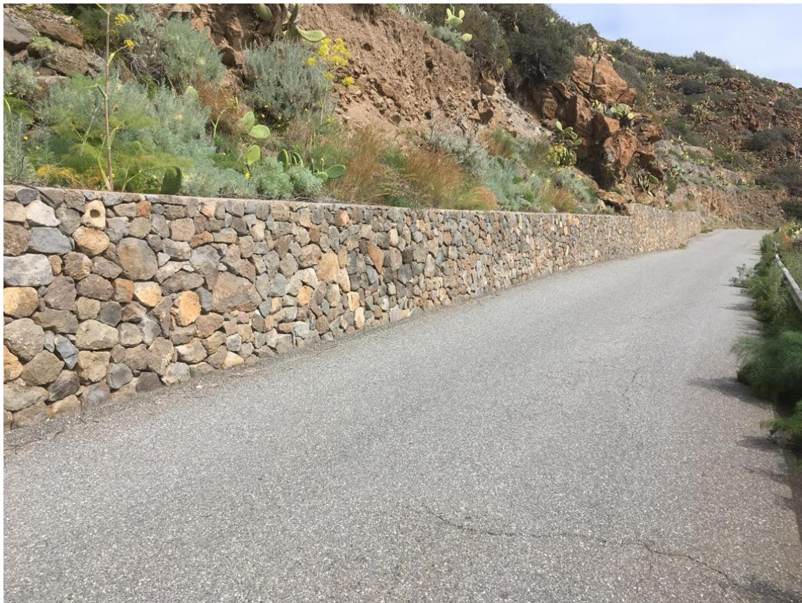
Foto 20 - Tratto sprovvisto di rete da trattare con disgaggi e sottomurazioni locali e installazione di rete e funi ancorate sopra esistente muro (IMG 4183 del 19 03 202 12:05). INTERVENTO 9 -TIPO A- su 4000m<sup>2</sup>
