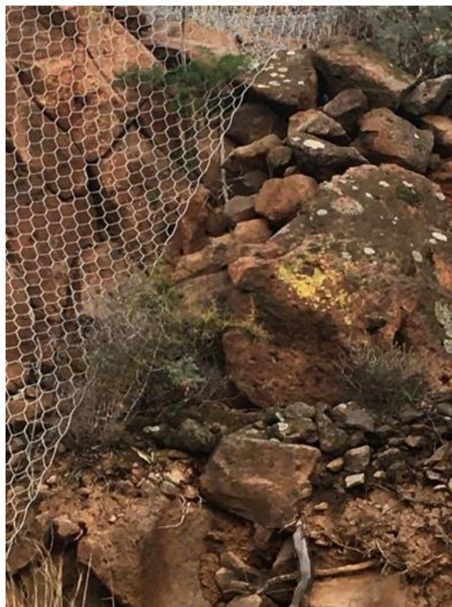
Foto 5 - Particolare inizio di rete nella foto precedente ed ubicata nello stralcio planimetrico sopra riportato, da rinforzare con funi e ancoraggi (IMG 4130 del 19 03 2021 06:47). INTERVENTO 6 -TIPO C- su 2250m<sup>2</sup>
