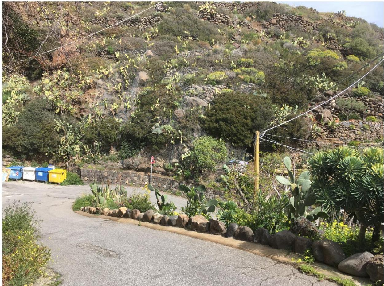
Foto 41 - Rete leggera da irrobustire con funi ancorate, ubicata nello stralcio planimetrico sopra riportato (IMG 4215 del 19 03 202 12:40). INTERVENTO 15 -TIPO F, G e C – rispettivamente su 50, 50 e 800m<sup>2</sup>
